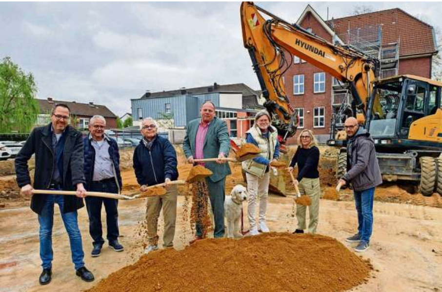
Beim Spatenstich zur Erweiterung der Grundschule „An der Burg“ waren anwesend (v. l.): Thorsten de Haas, Dr. Achim Ortmanns, Josef Viethen, Bürgermeister Bernd Jansen, Schulhund Lucy, Dirk Gröbert, Stefanie Buchkremer und Michael Keller.
